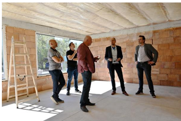
Besuch auf der Baustelle der Demogebäude auf dem Gelände von GBS in Sofia.
