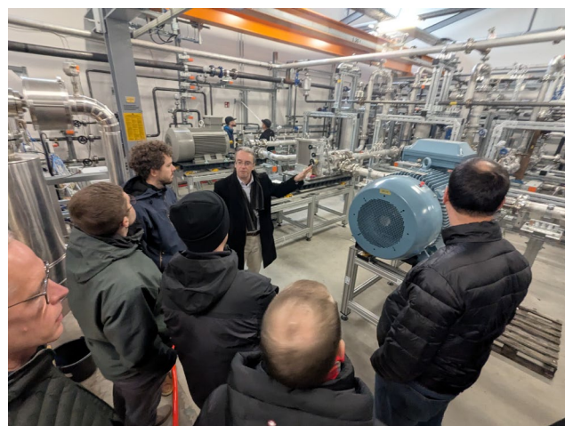
Einblick in eine industrielle Versuchsanlage. Quelle/Copyright: Greenovate!
